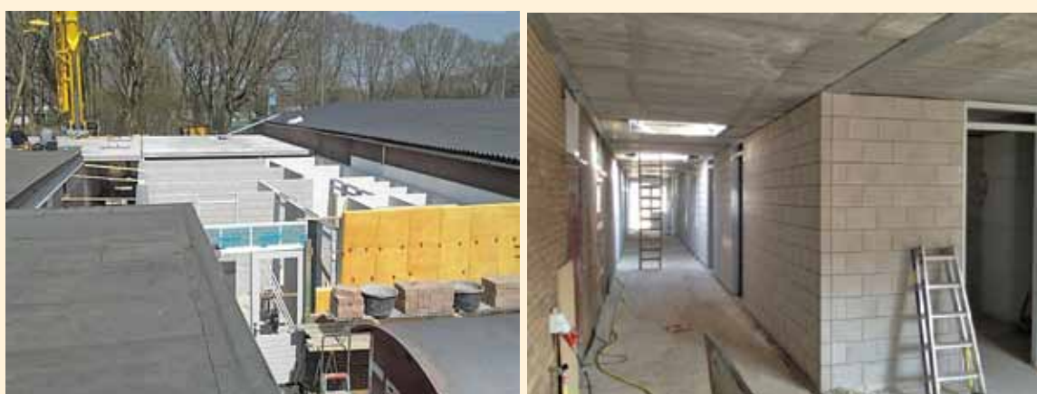
Bouw nieuwe kleedkamers in 2013
