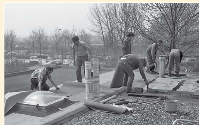
Deze foto van onderhoudswerkzaamheden aan het dak, geeft een indruk de uitbreiding van het clubhuis in de loop der jaren. Het grint vooraan ligt op het oorspronkelijke gebouw(tje).
