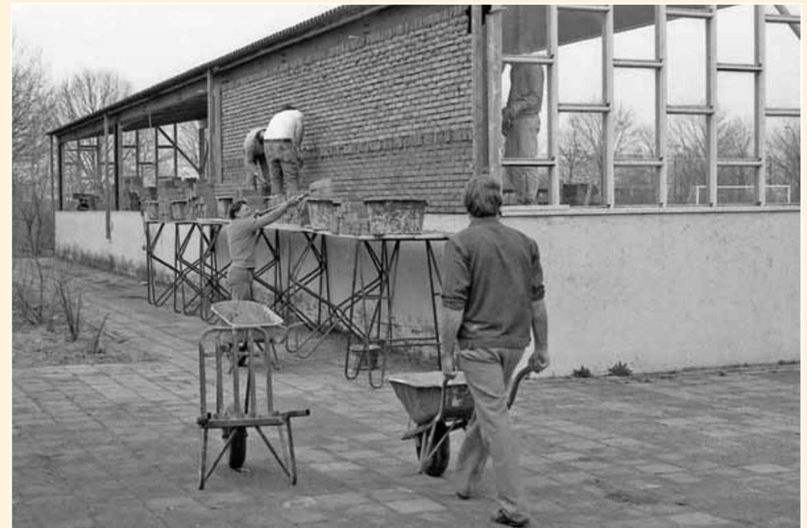
In 1973 werd naast het hoofdveld een tribune gebouwd. Aanvankelijk met een houten achterwand. Halverwege de jaren tachtig werd het hout vervangen door stenen.
